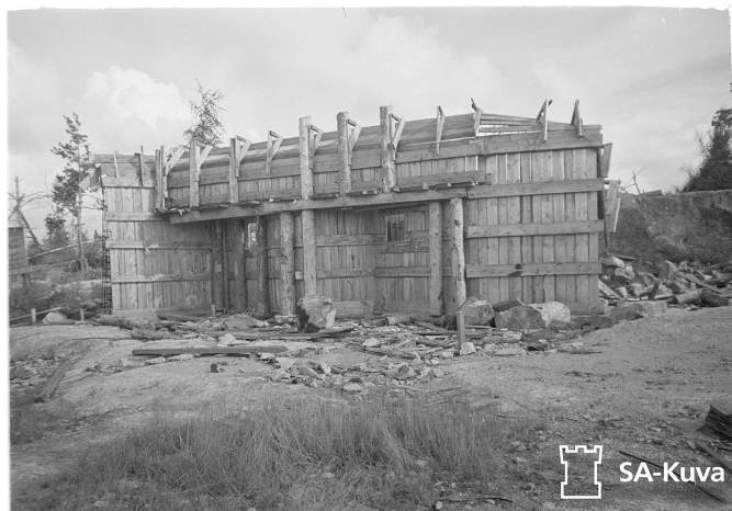
Полукапони́р. Каркас опалубки полукапони́ра [22].
