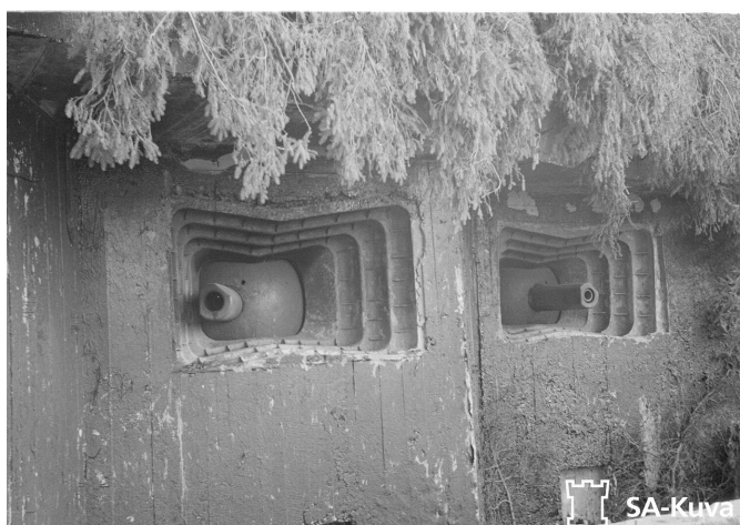
Артиллерийский полукапонир с установками Л-17 [22].
