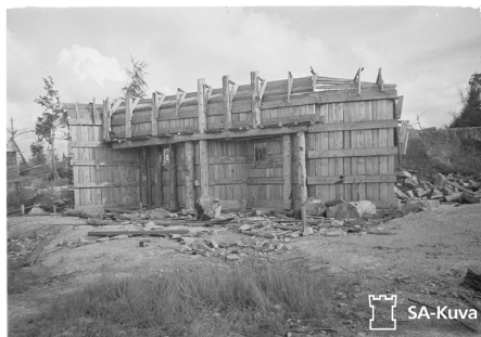
Полукапонир. Каркас опалубки полукапонира [22].
