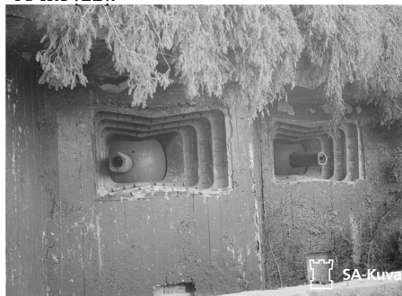
Артиллерийский полукапонир с установками Л-17 [22].
